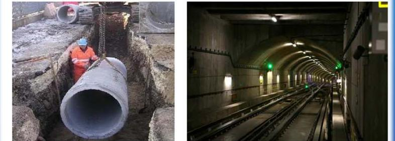
Fig.5.12-5.13: a sinistra è riportato un intervento di posa di un acquedotto, a destra un intervento di manutenzione di una galleria metropolitana.
